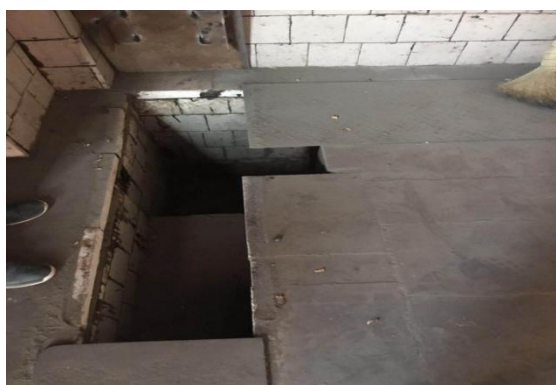
危险废物仓库防渗措施
